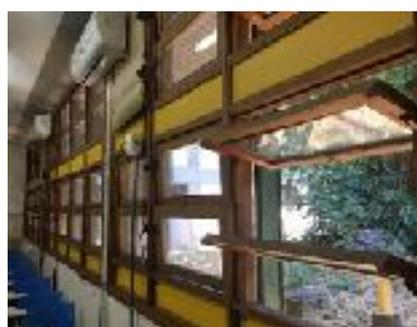
**Figura 16 - Sistema de abertura prejudicado pela instalação do ar condicionado.** Fonte: Acervo Pessoal (20/05/2017).
