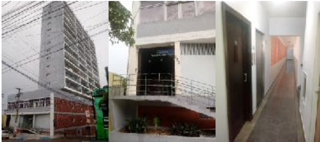
Figuras 02, 03 e 04 – Fachadas do edifício; Acesso ao edifício pela Av. General Osório; Corredor de acesso aos elevadores. Fonte: Acervo do grupo, 2018.
