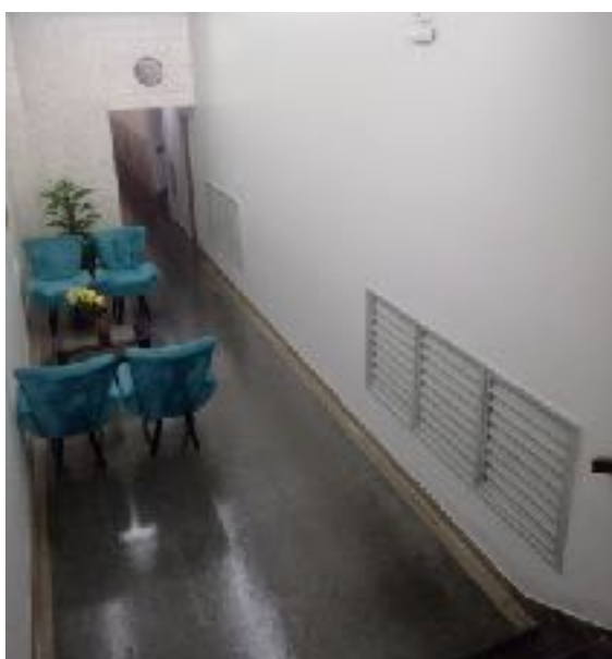
Figura 07 - Saídas de ar entre os setores de serviço e o hall do prédio. Fonte: Acervo do grupo, 2018.
