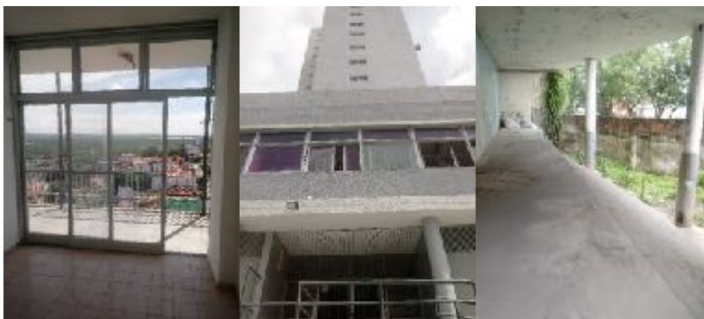
Figuras 16, 17 e 18 – Esquadria dos quartos; Fachada voltada para a Av. General Osório; Pilotis do antigo acesso à farmácia da INAMPS. Fonte: Acervo do grupo, 2018.
