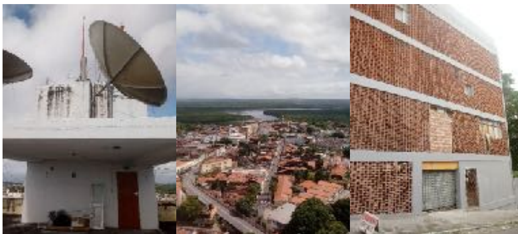
Figuras 12, 13 e 14 – Casa do zelador com antenas; Vista da cobertura do Edifício; Acesso ao atual espaço destinado ao abrigo de veículos. Fonte: Acervo do grupo, 2018.
