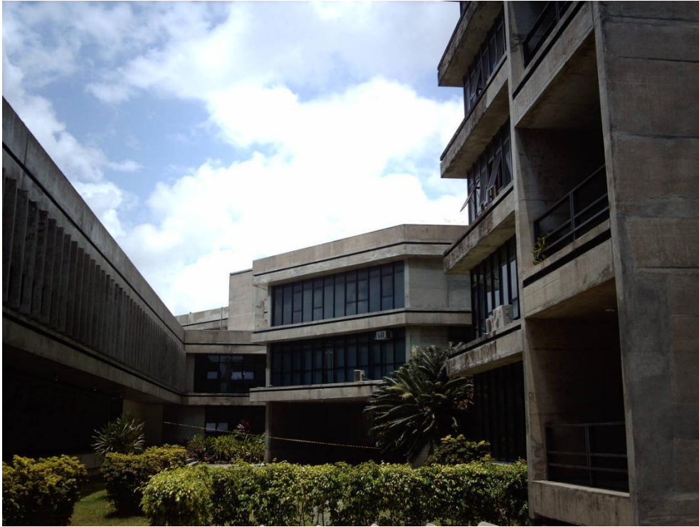
Figura 32 - Vista do pátio interno e dos desníveis dos blocos.
