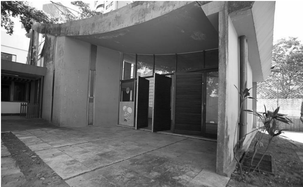
Figura 25 - Vista do bloco social central e de seu terraço.
