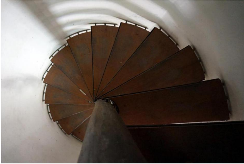
Figura 23 - Vista da escada helicoidal.
