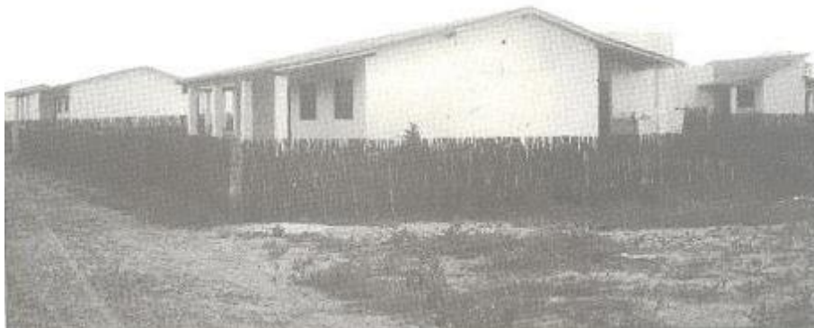
Figura 4 - Residência ampliável dos colonos.
