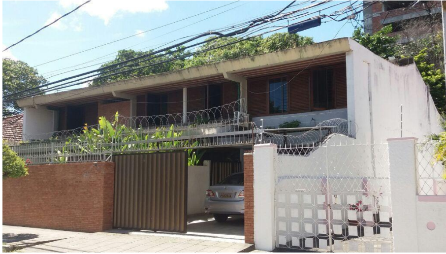
Figura 13 - Vista externa da residência e do sistema de vigas e pilares que suportam a cobertura de laje nervurada curva.
