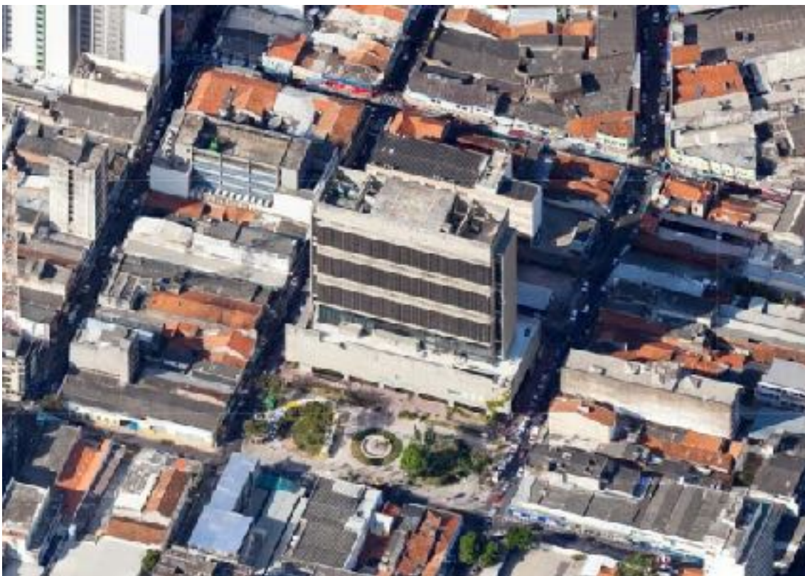
Figura 3 – Vista sudeste da sede do Banco do Nordeste do Brasil. Fonte: Imagem de satélite adaptada do Google Earth.
