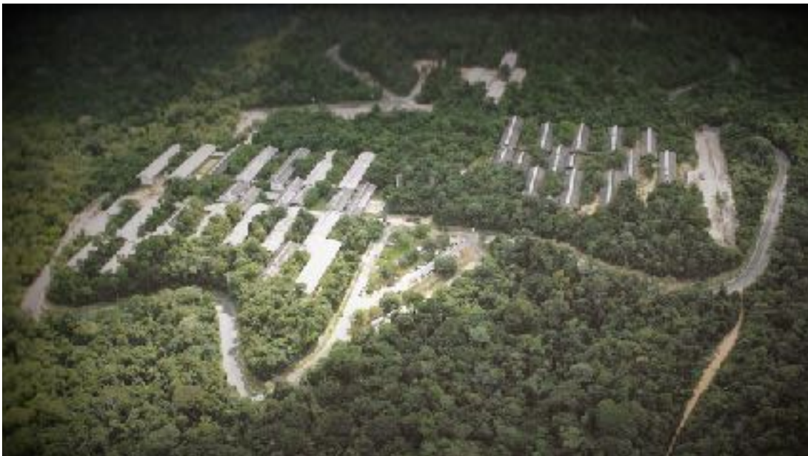
Figura 1 – Imagem aérea do Setor Norte da UFAM. Fonte: Sampaio apud Abraham, 2014.
