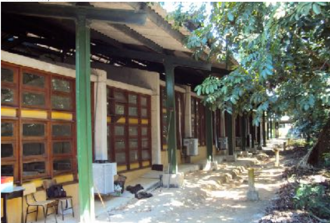
Figura 4 – Bloco de salas de aula 04 - ICHL. Fonte: Mendes, 2017.
