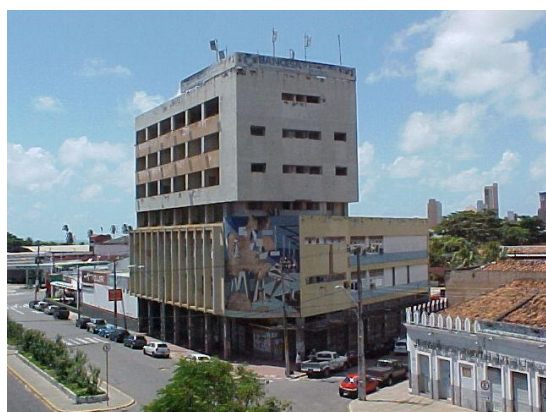
Figura 14: Centro de Exportadores do Ceará, foto do edifício degradado no fim da década de 1990. Fonte: Acervo do arquiteto.
