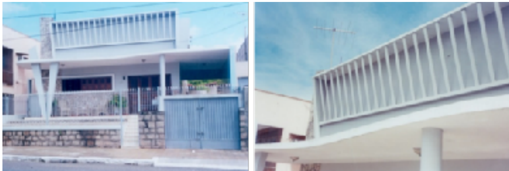
Figura 6: Residência da Av. Alexandrino de Alencar número 864, explora a plasticidade do concreto armado na fachada.
