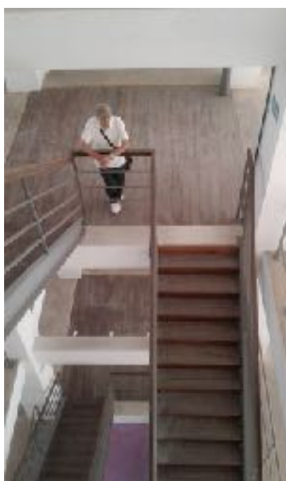
Figuras 11 e 12: Vista Interna da Caixa D’Água após a inserção da escada e mezaninos internos, distinguibilidade e valorização do vazio e leitura da estrutura. Fonte: Natália Vieira, 2014 e 2016.
