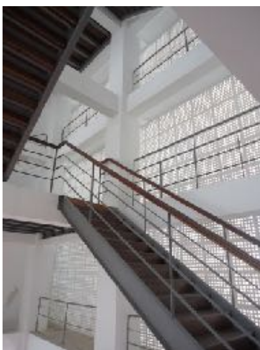
Figuras 11 e 12: Vista Interna da Caixa D’Água após a inserção da escada e mezaninos internos, distinguibilidade e valorização do vazio e leitura da estrutura. Fonte: Natália Vieira, 2014 e 2016.
