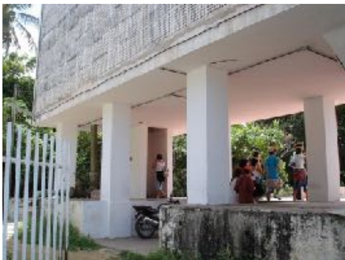
Figuras 05 e 06: Pilotis com colunas “encamisadas” e abertura do projeto original fechada no primeiro pavimento como resultados da intervenção na década de 70, e inserção de diversas antenas na laje de cobertura no finalzinho dos anos 90 e início 2000. Fonte: Natália Vieira, 2006.
