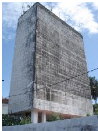
Figuras 05 e 06: Pilotis com colunas “encamisadas” e abertura do projeto original fechada no primeiro pavimento como resultados da intervenção na década de 70, e inserção de diversas antenas na laje de cobertura no finalzinho dos anos 90 e início 2000. Fonte: Natália Vieira, 2006.
