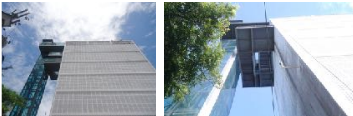
Figuras 16 e 17: Elevador panorâmico da Caixa D'Água após a inserção da escada exigida por questões de segurança (incêndio). Fonte: Natália Vieira, 2014; Natália Vieira, 2016.
