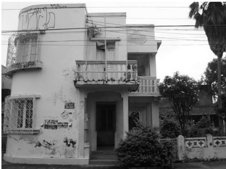
Figura 01: Casa da Cultura, na Avenida Jaime Brasil – Centro de Boa Vista. Monumentos tombados pelas entidades que deveriam zelar pela manutenção do patrimônio histórico, em nítido processo de degradação. Fonte: Ayana Dantas, 2015.
