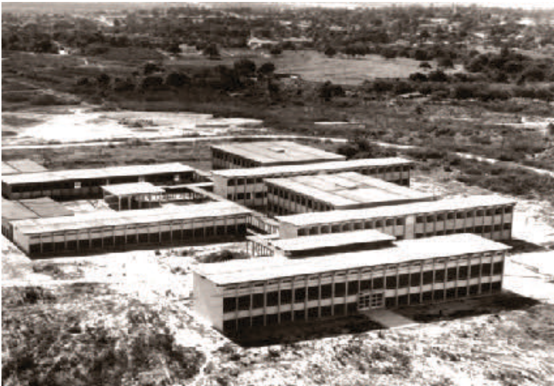
Figura 6 - Vista Aérea do campus do Pici. Década de 1970. Fonte: CAMPELO, 2012.
