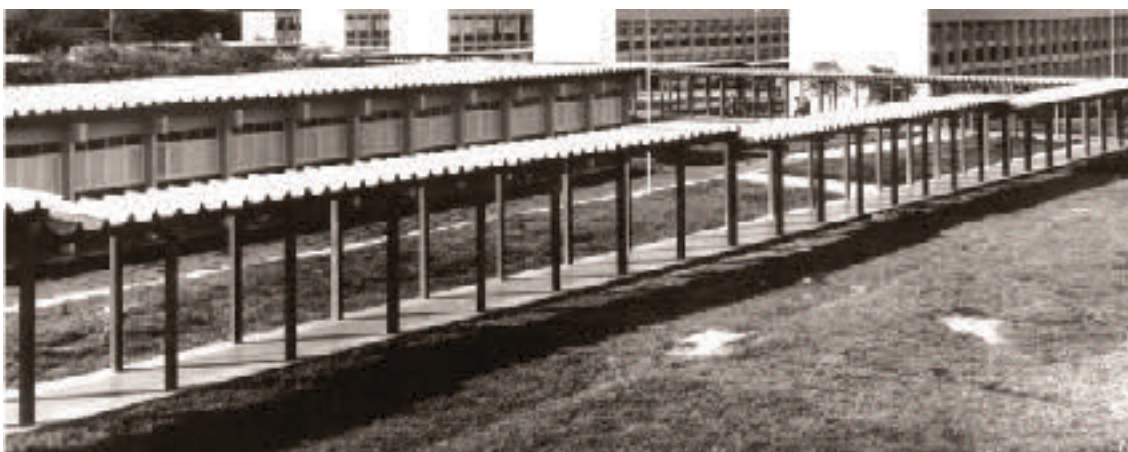
Figura 5 - Vista dos blocos articulados por passarelas. Campus do Pici. Fonte: CAMPELO, 2012.
