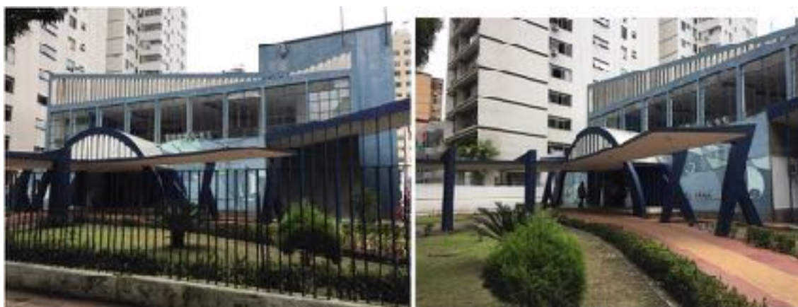
Figura 4 – Sede Social do Clube do Remo (1959-1960) . Fonte: Autor (2018).
