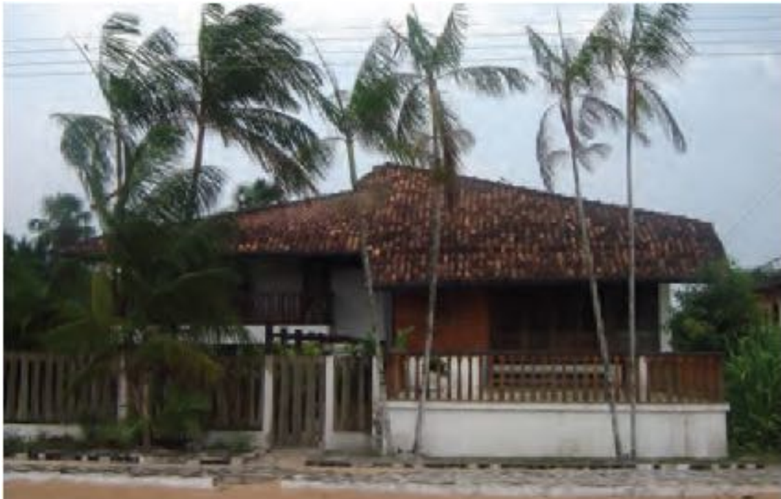
Figura 6 – Residência Elias Kamlume (1977-1978). Fonte: Giovanni Blanco Sarquis, 2009 apud Sarquis (2012).
