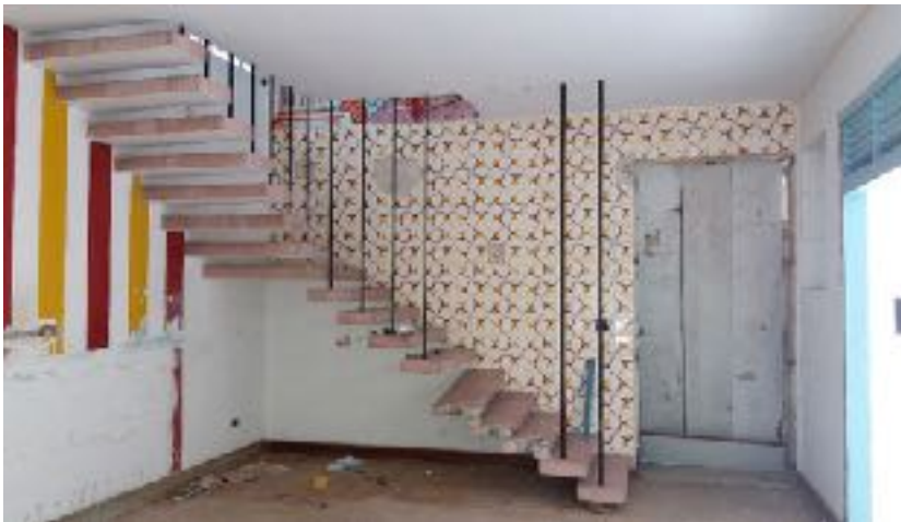
Figura 9 – Escada do imóvel nº 625. Fonte: Maria Luiza Freitas, 2018.
