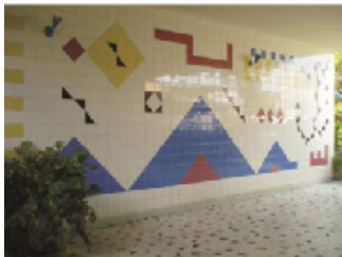
Figura 13 – Painel de azulejos presente na edificação, demonstrando a ligação do arquiteto com as artes plásticas. O piso ainda em perfeitas condições e a presença das duas arandelas presas ao painel. Fonte: Mariana Alves, 2008.
