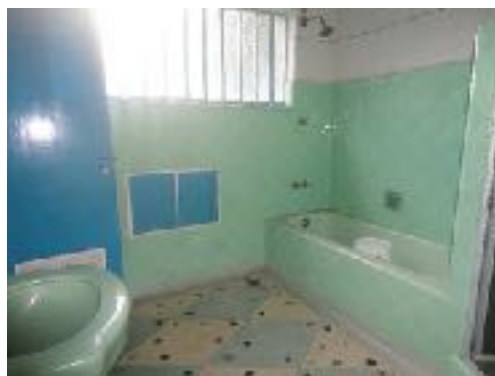
Figura 27 – Janelas e portas de madeira ainda preservadas. Furos nas juntas dos azulejos da parede da direita. Cinco azulejos próximos às torneiras, apresentam indícios que não são originais. Outros, apresentam sujeira. Fiação aparente seguindo do box até o exterior da edificação. Fonte: DPPC, Maio, 2016
