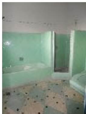
Figura 24 – Parede do banheiro com revestimentos de azulejos verdes, resguardando ainda as devidas características originais da época de construção. Piso resgatando a mesma unidade das áreas molhadas do terraço térreo. É possível ver a banheira preservada, o box com portas, as saboneteiras embutidas, o detalhe do rodapé e acabamentos. Há uma fiação aparente, não pertencente ao projeto original e o chuveiro do box foi retirado. Fonte: DPPC, Maio, 2016
