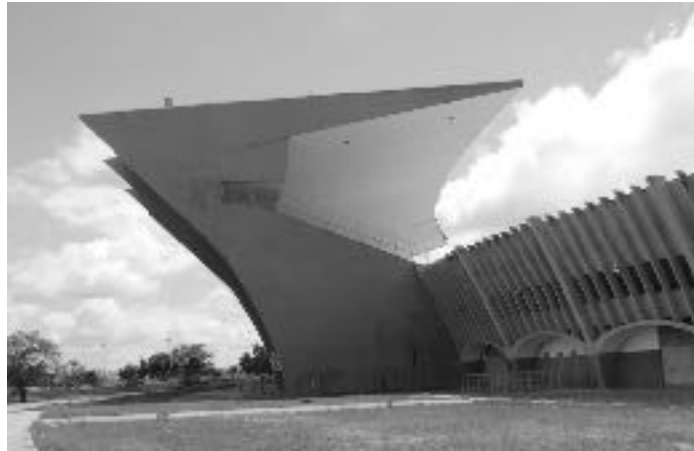
Figura 10– Arrojo estrutural da marquise das arquibancadas principais. Fonte: Fotografia da autora. Maio.2018.
