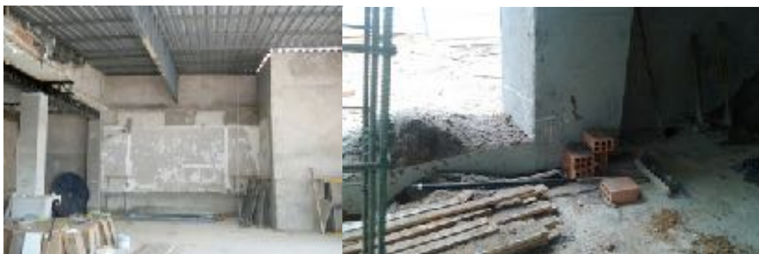
Figuras 4 e 5 - Sucessivas alterações no nível interno da Residência. Alguns dos níveis originais estão marcados pela mancha em cimento na parede à esquerda. Adição de treliças metálicas pelos locatários anteriores (25 abr 2018 e 8 mai 2018, respectivamente).
