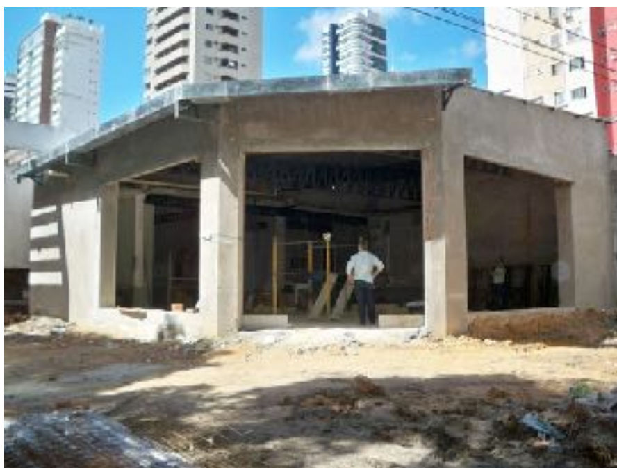
Figura 3 - Elemento chanfrado na fachada principal da residência (25 abr de 2018) Foto: Rodrigo de Lima
