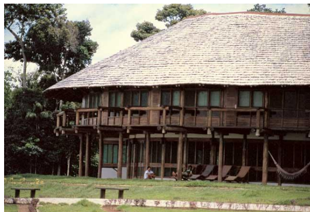
Figura 10 - Forte presença da madeira na constituição da Pousada Fonte: Cleidiane Santos, 2015 5 .
