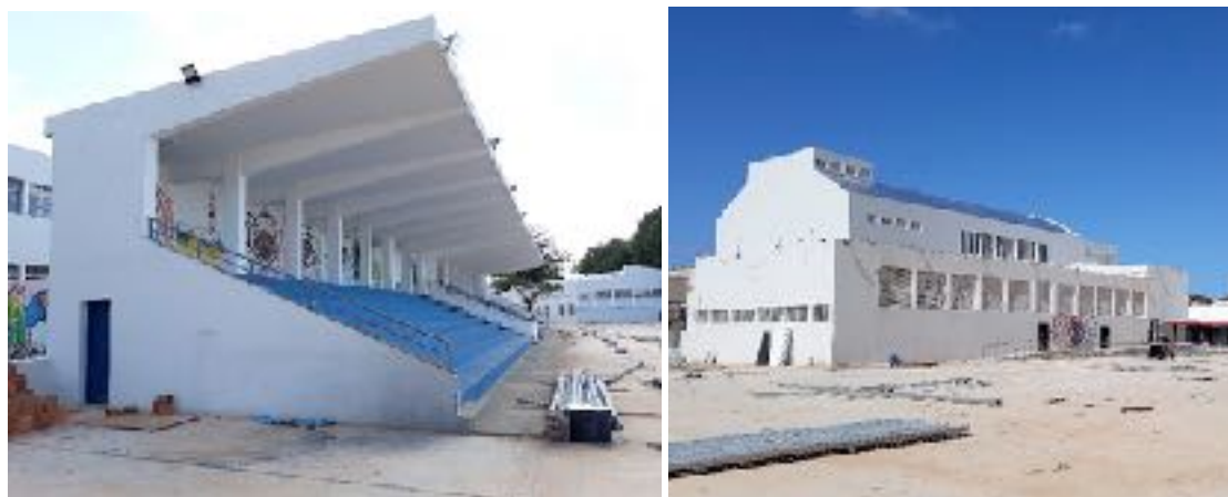
Figuras 10 e 11 – Arquibancada da pista de esportes e quadra principal. Fonte: Ana Bierrenbach (2018)
